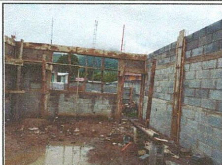
Foto 1: Paredes de block en construcción.
