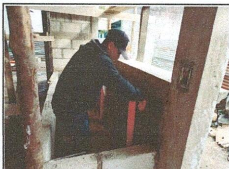
Foto 3: Construcción de la pileta de concreto para el lavado de trastes y verduras.
